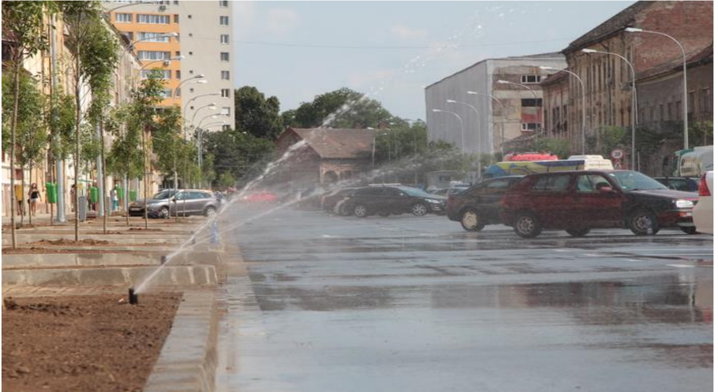
انخور 4 : د اوبه شیندونکي سیستم دا بیلگه هم د سرک مینځلو او هم د گلدان ته د اوبه ورکولو لپاره کارول کیږي
